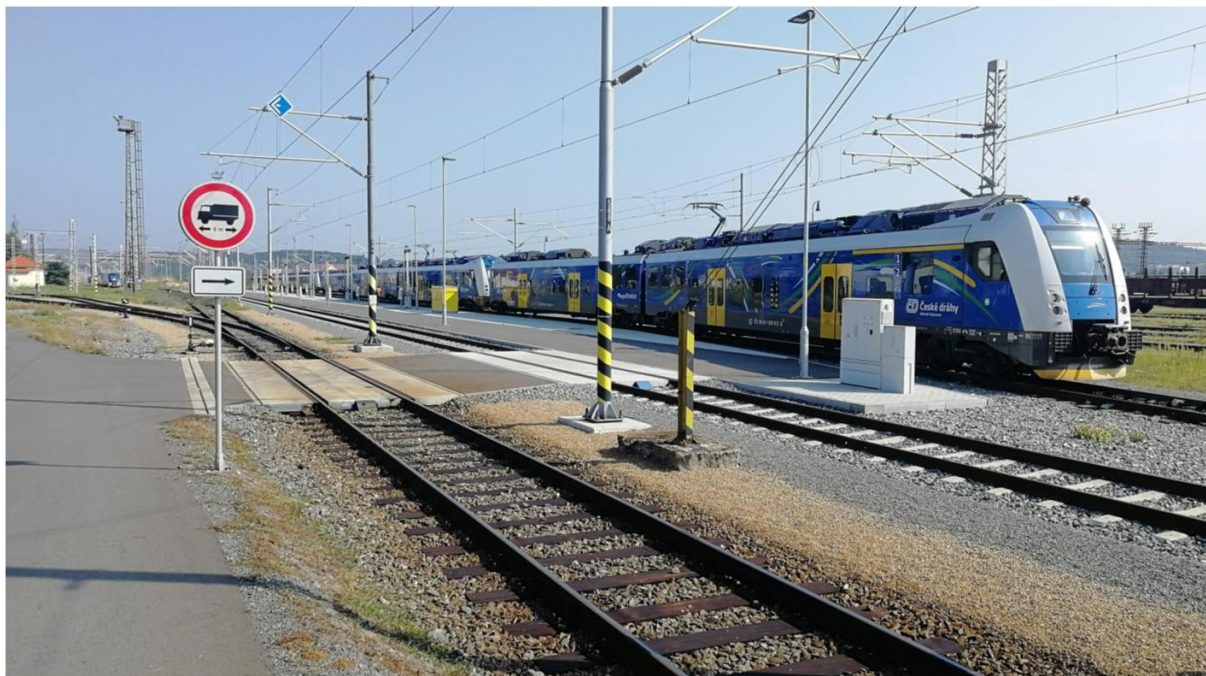
Obrázek 4. Úrovnňové křížení v současném stavu, kdy je svislým dopravním značením omezena délka vozidla, které smí vjíždět na man. plochu
